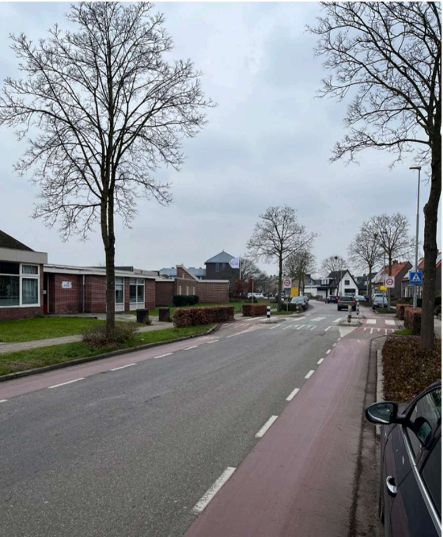
De school bestaat uit verschillende bouwvolumes in een groene voortuin aan de Dorpsweg.
